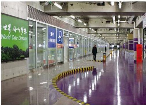
首都机场三号航站楼地下停车场使用公司防火中空玻璃隔断（带钢框架防火玻璃门）
